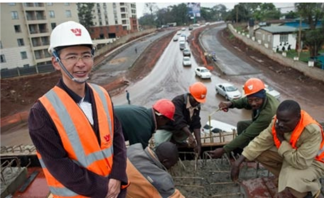
Đầu tư của Trung Quốc vào Kenya để xây dựng một con đường
